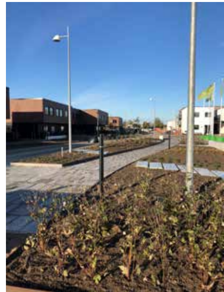
Den første kvarterplads i Nærheden – dog er træerne endnu ikke plantet. Pladsen giver afveksling i vejforløbet og nedsætter samtidig kørehastigheden.
